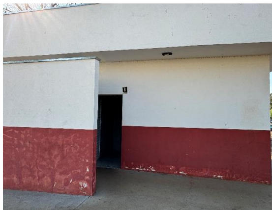
Entrada do banheiro feminino.
