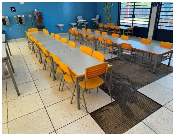
Piso do refeitório.
