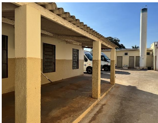
Área interligada dos fundos do Cras e da UBS.
